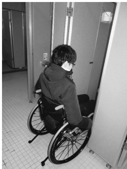
図3 一般の個室トイレ 入口の有効幅員は80cm以下であり、 車いすに乗ったままトイレに入ること は困難である。
