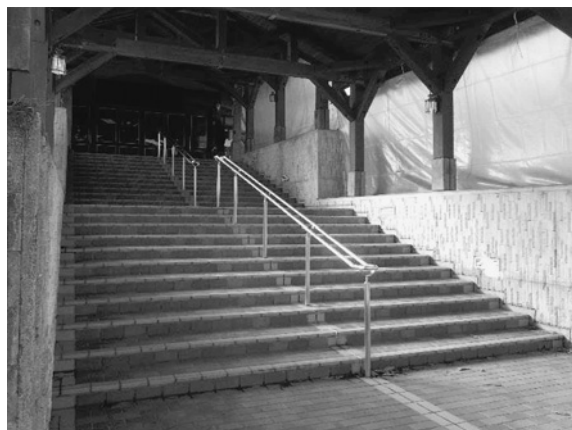
図1 レストハウス前の階段 Bスキー場のレストハウスの一つは入り口に階段があり、階段下の呼び鈴を押すとスタッフがサポートに降りてくる。
